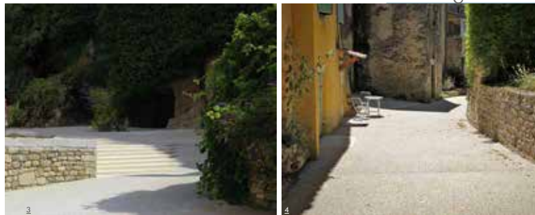
3/ Autour de la grotte, des gradins en pierre et béton aspect calcaire ont été disposés pour former un petit 'théâtre'. 4/ Les seuils des résidences, véritables connexions entre l'espace privé et public, ont été traités en béton décoratif. La granulométrie est fine et la couleur identique aux pavés et aux pierres.
