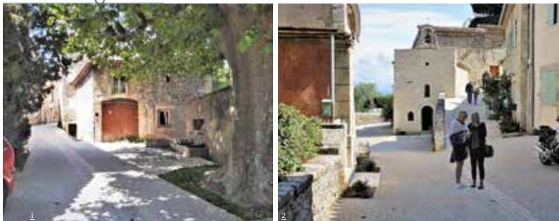
1/ Étroites et typiques des petits villages de charme, les ruelles ont été revêtues de macro-béton, appelé aussi 'béton caladé' en raison des granulats grossiers qui le composent (Ø 2,5 cm et au-delà), et de pavés (10 x 10 cm). 2/ En pied de façades, les massifs, entretenus par la population, ont été conservés. Parmi les essences plantées, d'inspiration méditerranéenne, on peut citer des lauriers 'tin', des cistes, des pittosporums, des filaires, des sauges...
